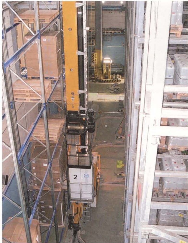
↑ Abb. 2: Neues Regalbediengerät (vorne) und alter Stapelkran (hinten) während der zweiten Umbauetappe
